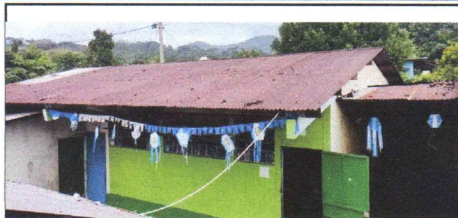
Foto 2: Sustitución de lámina, por lamina troquelada aluzinc calibre 26
