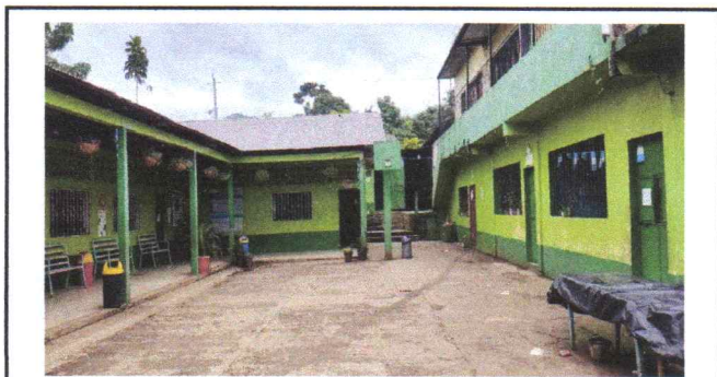
Foto 5: Pintura en muros exteriores.
