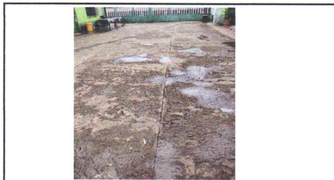
Foto 4: Sustitución de piso de torta de concreto.
